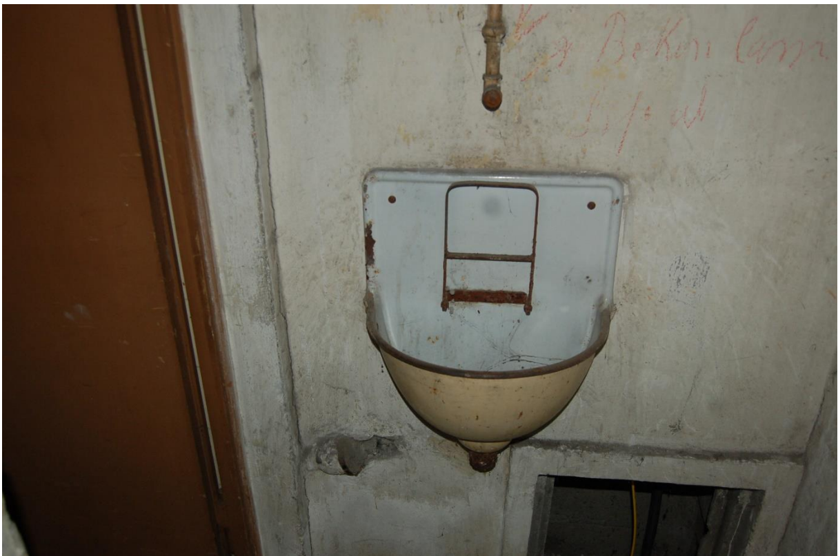
Abb. 14: emaillierte Waschbecken am Ende eines jeden Flures (rechts unten ein geöffneter Abluftschacht)
