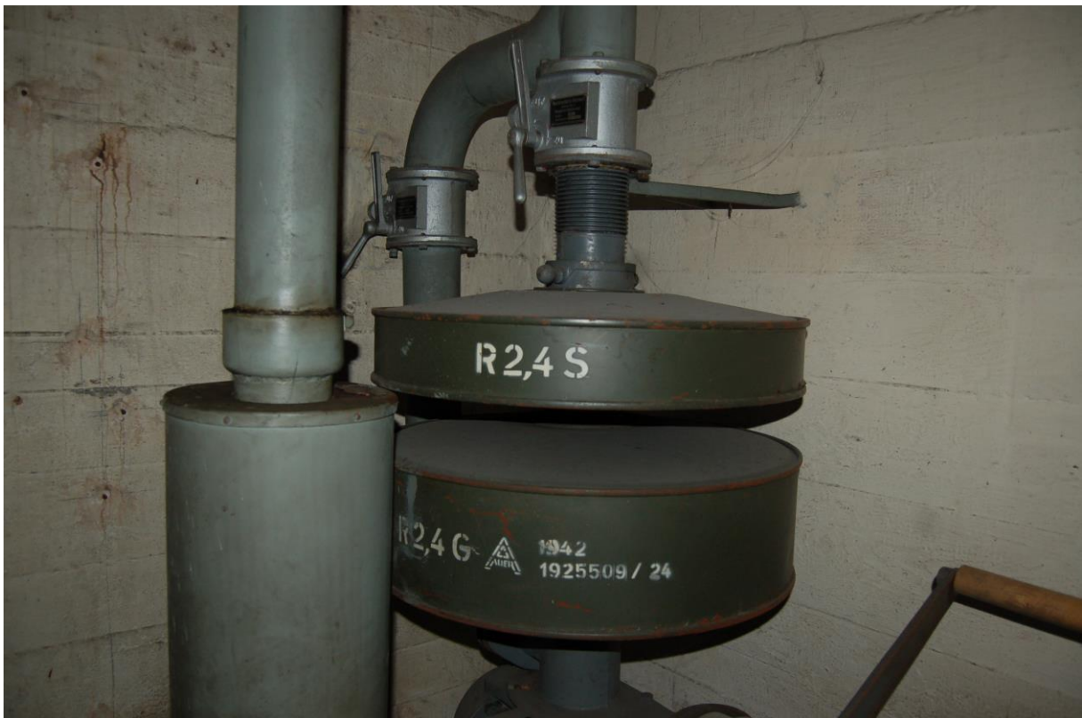
Abb. 23: die beiden Filter (Vor- und Hauptfilter) und darüber die Umschaltventile, die Filteranlage wurde 1942 hergestellt und eingebaut
