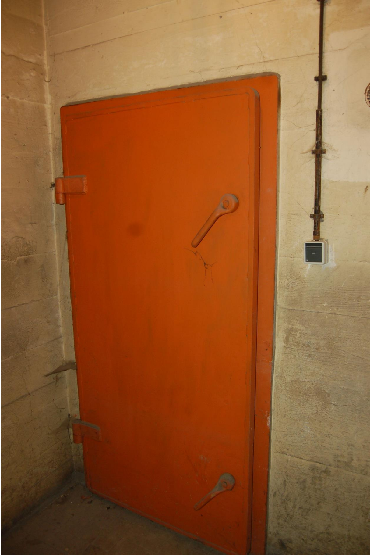
Abb. 05: eine der Gasschleusentüren
