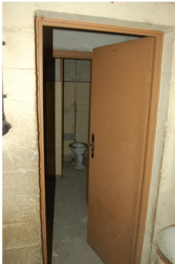
Abb. 17: Blick in den Vorraum (Waschraum), dahinter eine WC-Kabine
