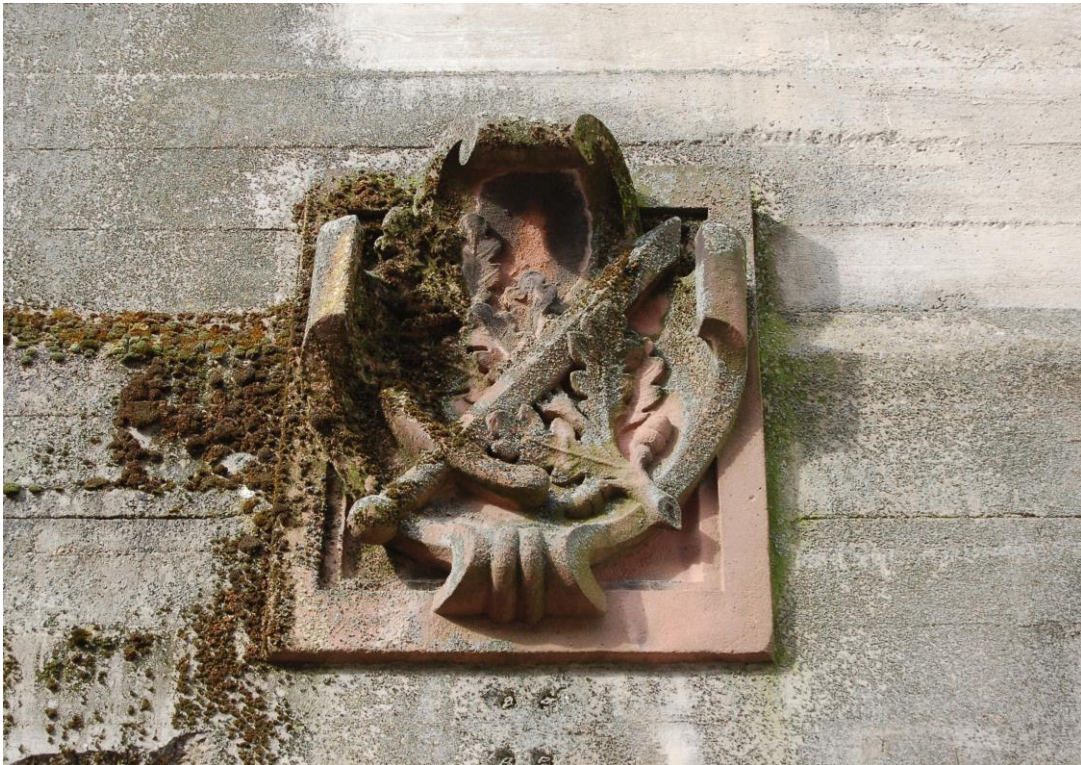
Abb. 03: Über dem Eingang Schanzstraße ist ein in Buntsandstein gearbeitetes Wappenschild in Form des „Spanischen Schildes“ (Iberische Form) mit Schwert auf Eichenlaub und drei Schutzfahnen angebracht. Eine Blasonierung des Wappens liegt leider nicht vor und die heraldische Zuordnung ist nicht bekannt.
