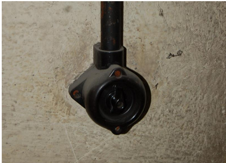
Abb. 25: Drehschalter aus Bakelit
