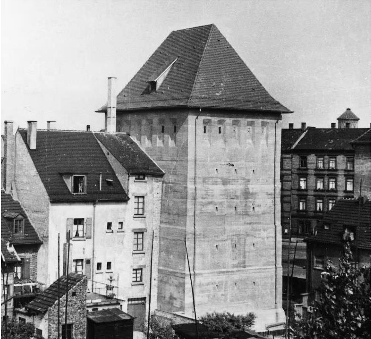
Abb. 32: Der Bunker im früheren Originalzustand von Westen gesehen, im Hintergrund am rechten Bildrand der Wasserturm Gräfenau im Hemshof Auszug aus einem Originalfoto, Datum der Aufnahme unbekannt
