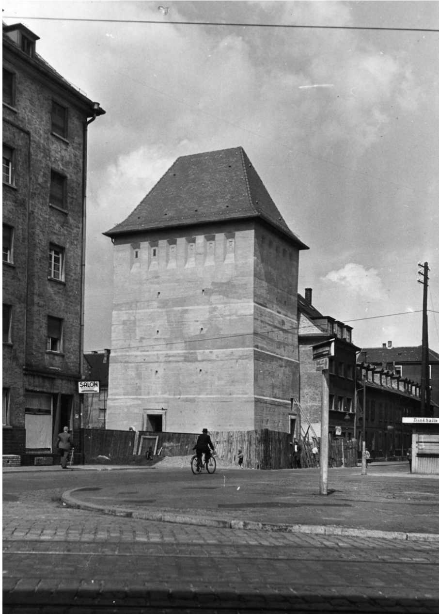
Abb. 33: Der Bunker im früheren Originalzustand von Südost gesehen, Originalfoto, Datum der Aufnahme unbekannt, jedoch lässt der Bauzaun auf einen Zeitpunkt kurz vor der Fertigstellung schließen
