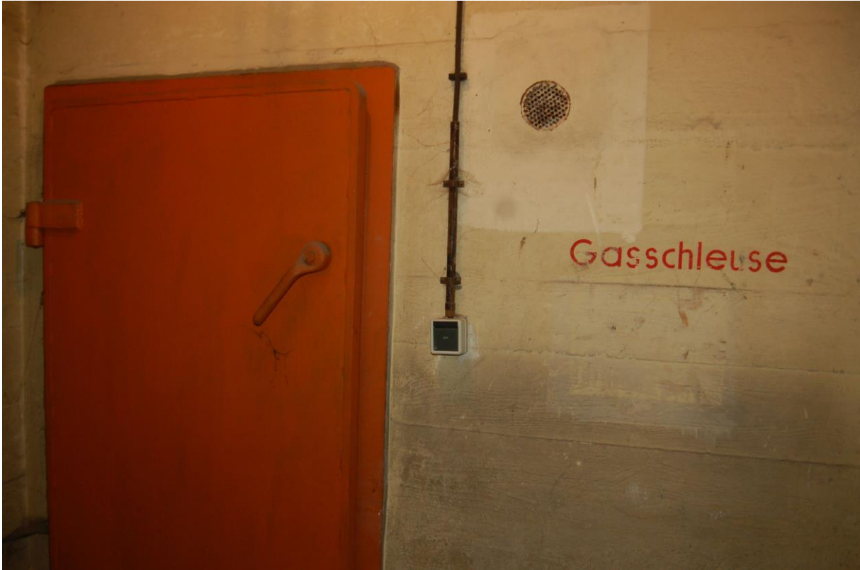
Abb. 06: Blick in die Gasschleuse Schanzstrasse
