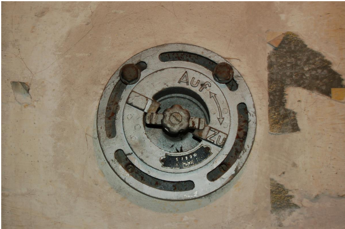
Abb. 08: einstellbares Überdruck-Schnellschlussventil, Druckangabe noch in „6 – 10 mm WS“ (entspricht etwa 0,6 bis 1 mbar)
