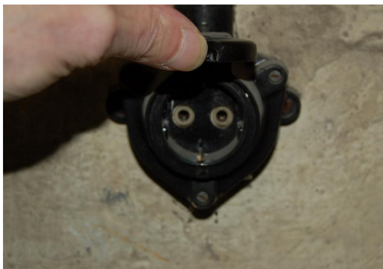
Abb. 26: der Bunker war bereits mit Schutzkontakt-Steckdosen ausgestattet
